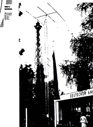
3-Element-Drehrichtstrahler auf einem etwa 18 m hohen Gittermast vor dem DARC-Pavillon
